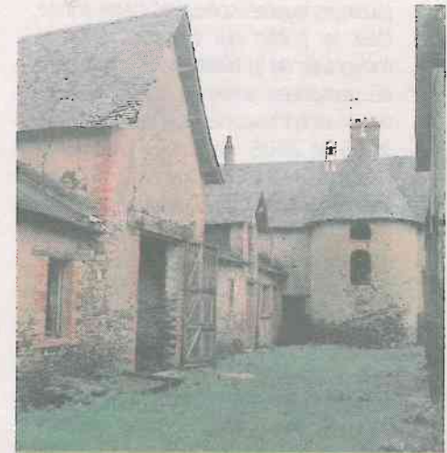
Toutes les organisations Rouges des prés vont s'installer au Domaine des Rues après les travaux.
